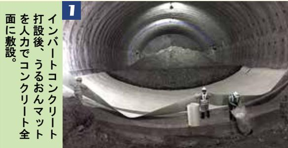
1 インバートコンクリート打設後、うるおんマットを人力でコンクリート全面に敷設。
