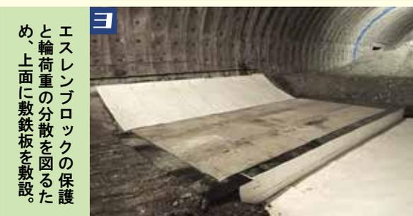
3 エスレンブロックの保護と輪荷重の分散を図るため、上面に敷鉄板を敷設。
