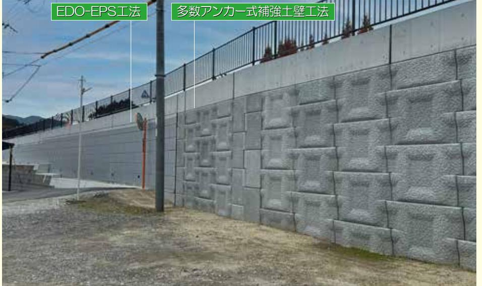
いられています。道路に近接して住宅や生活道路があるため、壁外側に足場を必要とせず、盛土側から構築できる多数アンカー式補強土壁工法によって可能な限り道路幅を確保。また、既存のブロック積みを一部残しながら施工が可能な軽量盛土のEDO-EPSを用いるなど、適材適所の工法をご提供しました。
