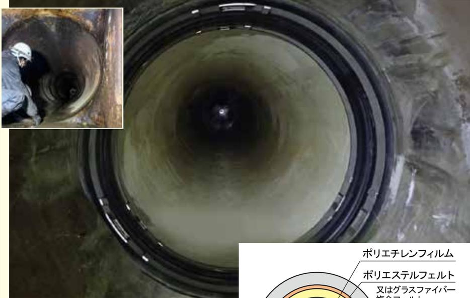
れ変わりました。特に一部の区間は管径1,800mmと、同工法で対応可能な最大径にて施工されています。
