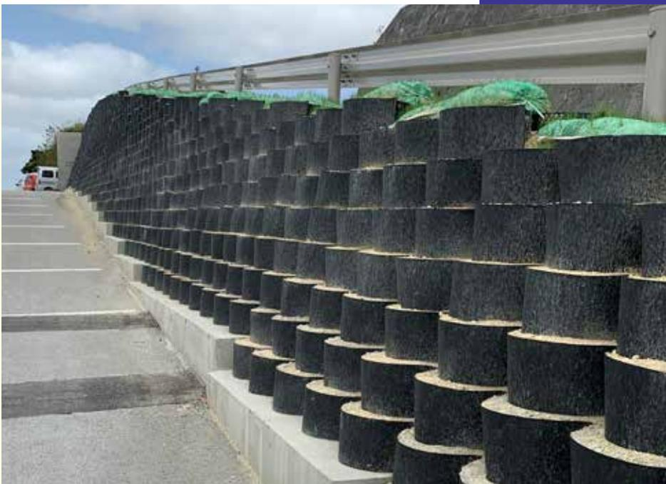
この工事において、正殿など焼失建造物が集中する中心の広場「御庭」のレベルまで工事車両と資材を導入するための仮設道路の補強盛土工法として採用されたのが、岡三リビ
