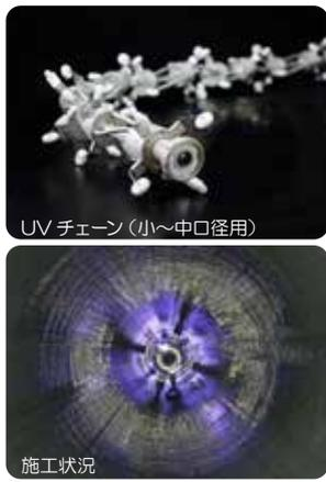
ガラス繊維製不織布に光硬化性樹脂を含浸した「SORS Liner」を用いる、紫外線照射による管更生工法です。マンホールから既設管内にSORS Linerを引込み送風機によってその内部を拡張した後に光照射装置「UVチェーン」を挿入し、管を形成していきます。
