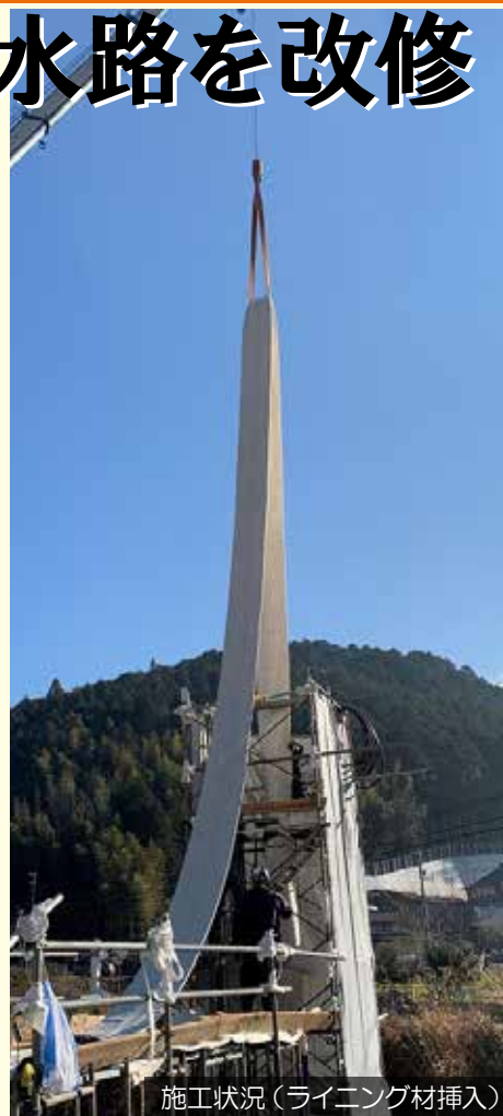
施工状況（ライニング材挿入部）
