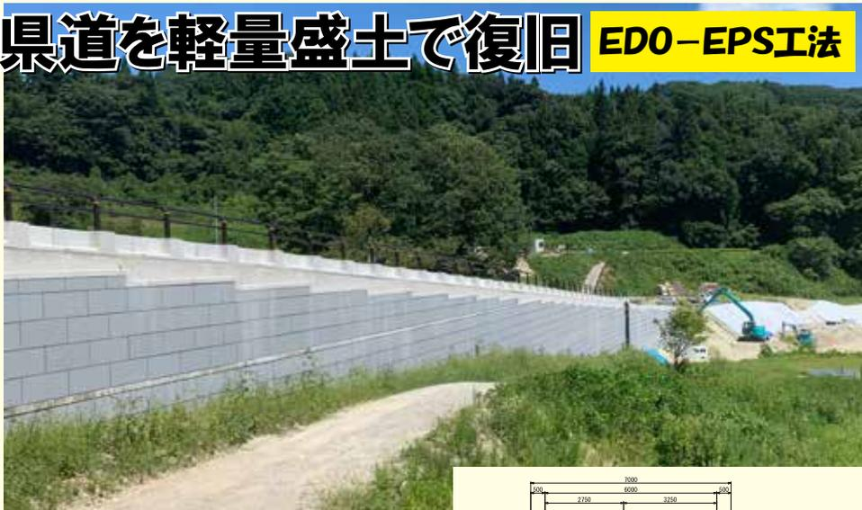
るため、「EDO- EPS工法」を用いることで、農林水産部による地下水排除工完工後の斜面の安全率1.15を道路築造後も維持することを念頭に計画。また滑落した区間は2つのヘアピンカーブを含んでおり、この線形を短絡化してヘアピン部を解消する狙いと同時に道路工事としての延長を抑えることで経済性にも配慮されています。
