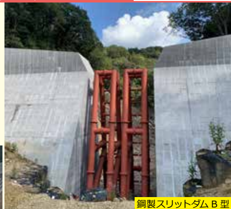
鋼製スリットダム B型
