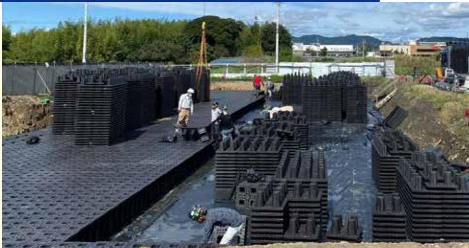
と、また現地は至近に流れる庄内川の浸水想定区域に含まれていることから、「ジオプールAE-1」を用いた貯留槽を敷地内に埋設し、流入する雨水への対策としています。
