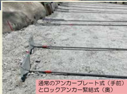
通常のアンカープレート式（手前）とロックアンカー緊結式（奥）
