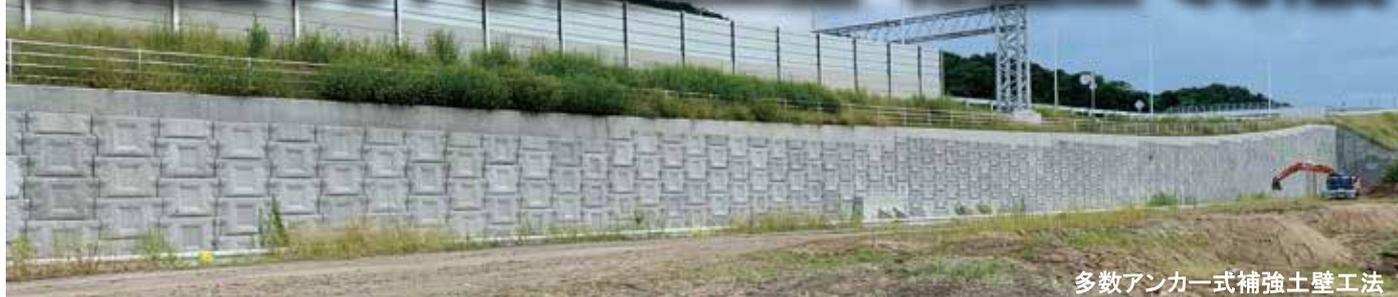
多数アンカー式補強土壁工法
