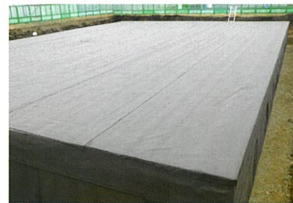
6 シート完了状況
