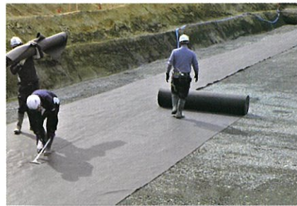
1 保護シート敷設
