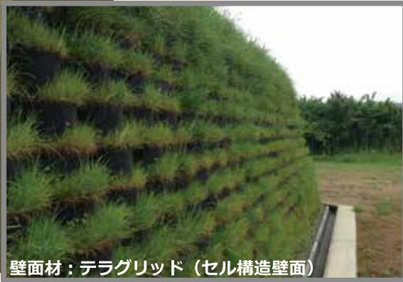
壁面材：テラグリッド（セル構造壁面）
