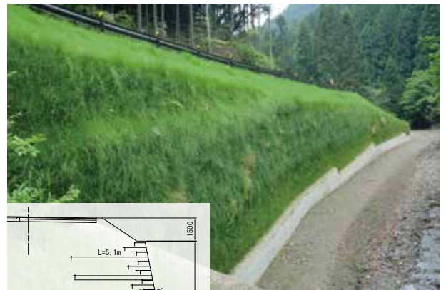
施工場所 和歌山県 壁面材 フラットパネル 壁高 7.7 m 壁面勾配 1 : 0.2
