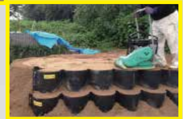
中詰め材敷均し・締固め
