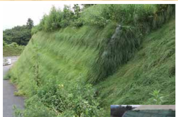
施工場所 長野県 壁面材 トリパネル 壁高 7.9 m 壁面勾配 1 : 0.3
