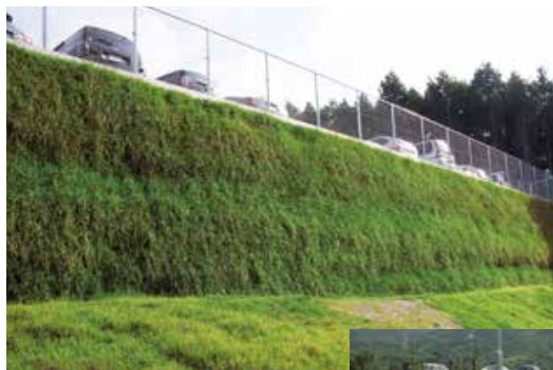
施工場所 山口県 壁面材 トリパネル 壁高 6.0 m 壁面勾配 1 : 0.1
