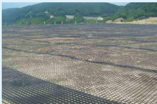
施工場所 佐賀県 盛土高 10.0 m 法面勾配 1 : 1.5
