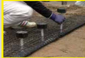
接続材の設置
