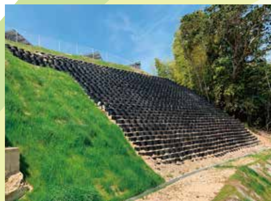
マルショウ運輸 洲本市太陽光発電所内災害復旧工事
