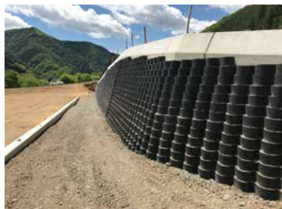
桐生市梅田台緑地改良工事
