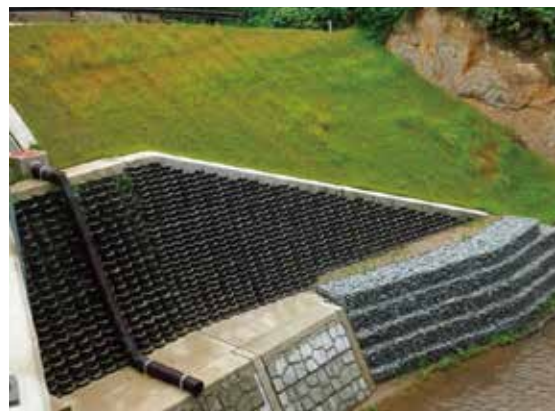
国道 304 号道路改良工事
