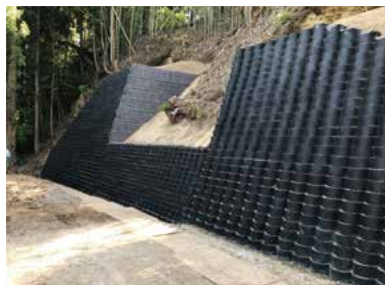
県単治山事業 尻高 (関田地内)
