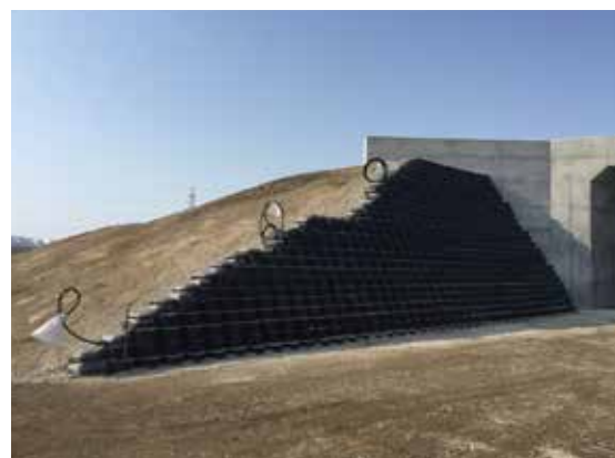
北海道横断自動車道 釧路市 山花西改良工事
