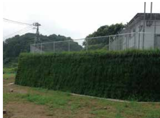
P/L 緊急遮断弁更新及び構造変更工事
