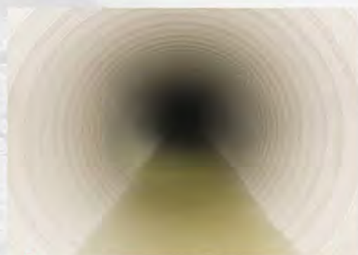
施工後（更生管）
