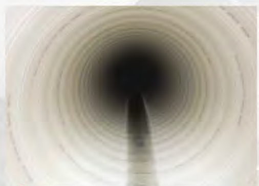
施工後（更生管）
