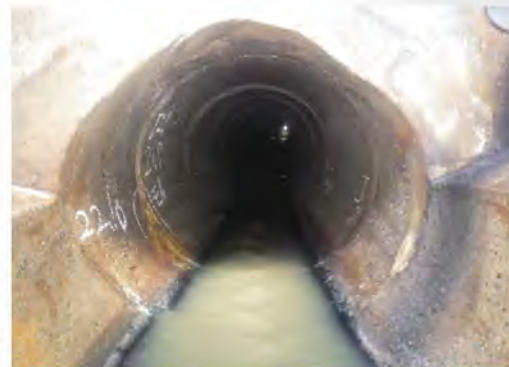
施工前（既設管）
