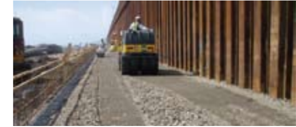
盛土転圧状況 Compaction of backfill
