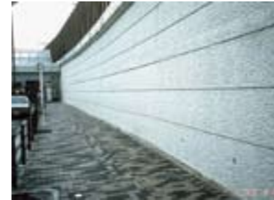
急勾配化工例 西日本旅客鉄道 六地蔵駅 JR-West, Rokuzizo station
