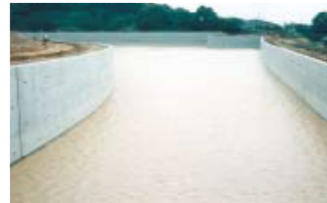
袋井春岡住宅造成工事（1995. 3） Residential area, Fukuroi (March 1995)
