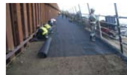
ジオテキスタイルの敷設状況 Placement of geogrid
