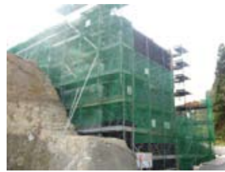
補強土耐震性橋台（北海道新幹線） 2011年10月 Abutment of GRS retaining wall (using bearings), October 2011
