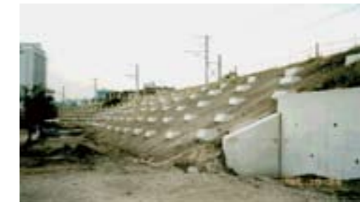
震災盛土の復旧状況（兵庫県南部地震による） Reconstruction of embankment damaged by 1995 Kobe Earthquake
