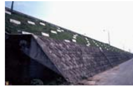
のり面補強施工例 熊谷バイパス Kumagaya bypass
