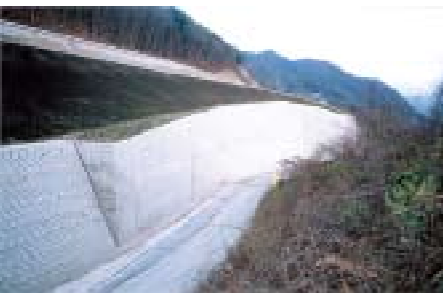
山形自動車道 滑川工事（1996. 12） Yamagata Highway, Namekawa (December 1996)
