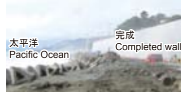
Restoration of a sea wall for seisho by-pass that collapsed by a typhoon 2007 to a GRS retaining wall. 平成19年の台風によって崩壊した西湘バイパス(神奈川県)海岸擁壁のGRS擁壁による復旧
