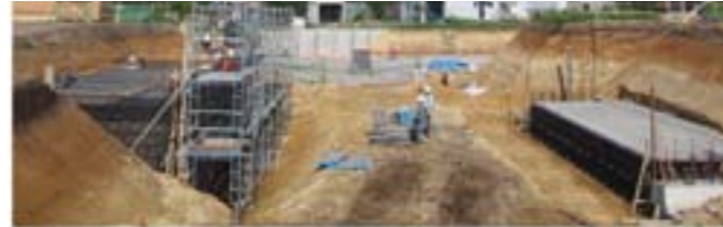
建設中のGRS一体橋梁（木古内） 2011年8月 GRS-integral bridge under construction (Kikonai) August 2011
