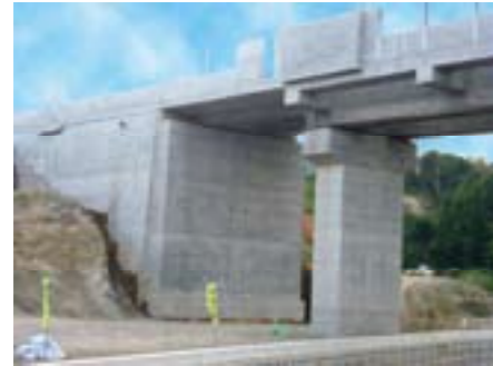
補強土耐震性橋台（北海道新幹線） 2012年8月 Abutment of GRS retaining wall (using bearings), August 2012
