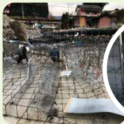
造形鉄筋に沿わせてラス網を結束線により固定
