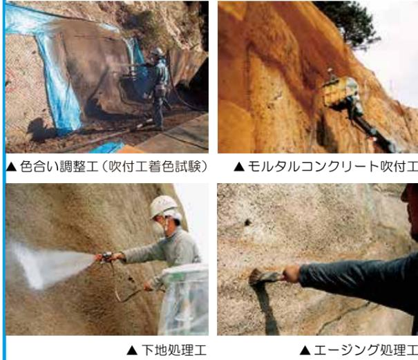
▲色合い調整工（吹付工着色試験） ▲モルタルコンクリート吹付工
