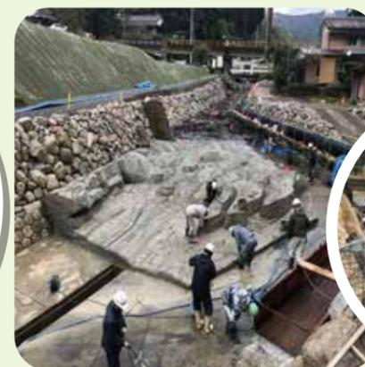
造形鉄筋とラス網の内部にコンクリートを充填
