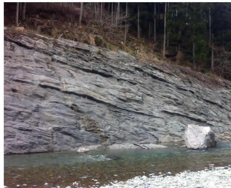
善徳護岸（徳島県三好市）▶
