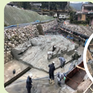
造形鉄筋とラス網の内部にコンクリートを充填 (外的応力がかからない動物園等では充填しない場合もあります)
