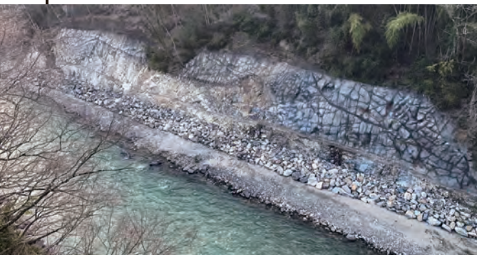
▲天竜川鷹流峡（長野県飯田市）【斜面カービング工法】※P14参照
