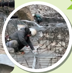
造形鉄筋に沿ってラス網を結束線により固定
