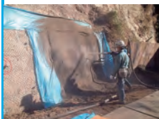
▲色合い調整工（吹付工着色試験）
