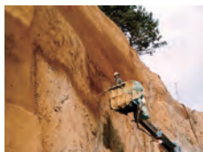
▲モルタルコンクリート吹付工
