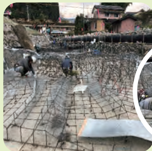
造形鉄筋に沿ってラス網を結束線により固定
