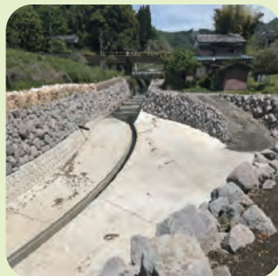
基礎となるコンクリートだけの状態
