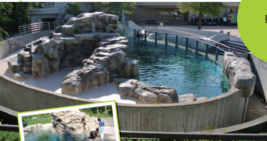
▲いしかわ動物園／アシカアザラシのうみ（石川県能美市） 老朽化した巖岩を補修し、施設をリニューアルしました。
