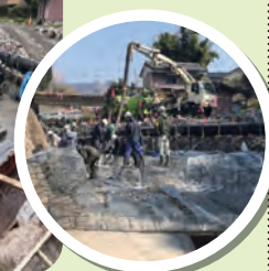
造形鉄筋とラス網の内部にコンクリートを充填 (外的応力がかからない動物園等では充填しない場合もあります)
