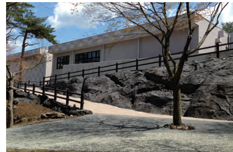
▲ふじさんミュージアム／外構リニューアル（山梨県富士吉田市） 駐車場から入り口に続くスロープ部には、高低差を調整するためのジオグリッドによる補強盛土とその表面に人工岩ロックステージによる溶岩風の修景が施されています。
