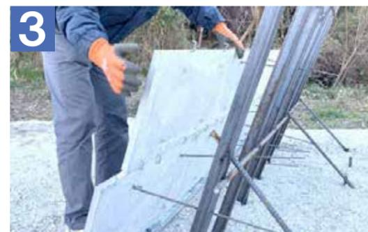
3 置くだけでガイドの結合機構によりラクパネどうしが結合するため、手を離しても転倒しない。
