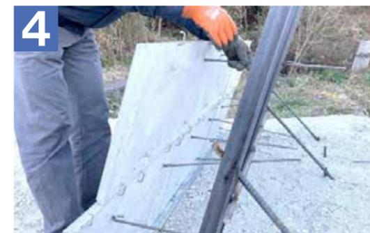
4 リングコネクターステンレスにU型セパを通し、支持材(アングル・鉄筋等)とを溶接で結合固定する。
