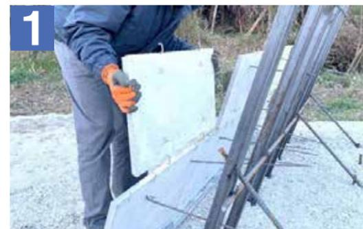
1 設置位置を確認しながら設置済みパネルの上端部に下ろしていく。
