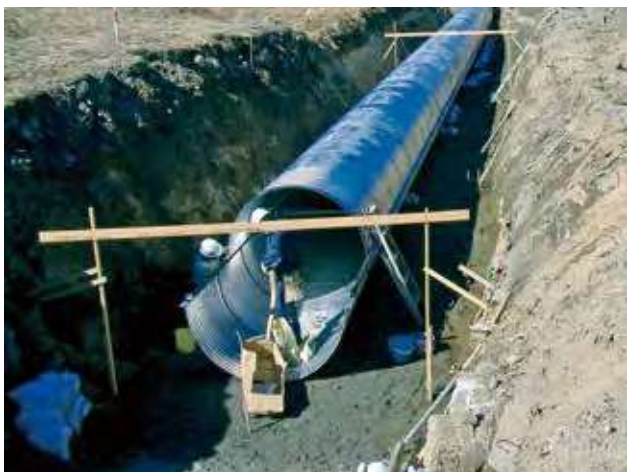
円形 1 形施工状況
