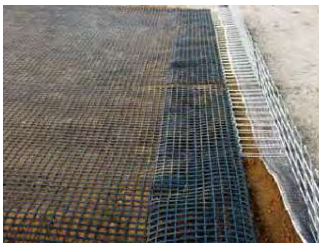
壁面材、トリグリッド設置状況
