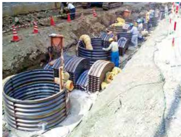
深礎施工状況
