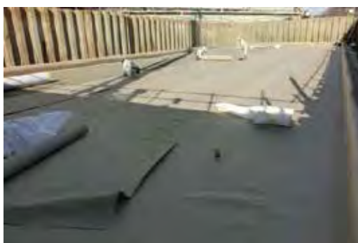
3. シート工 (底面・側面)
