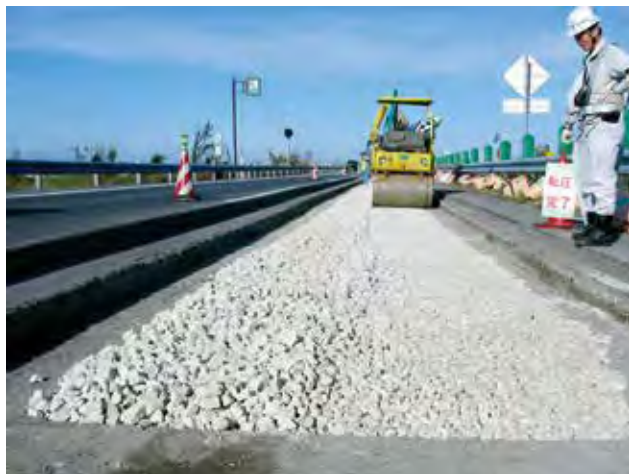
既設道路の沈下抑制
