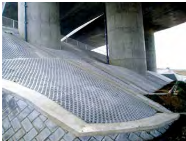
橋台下部の洗掘防止工
