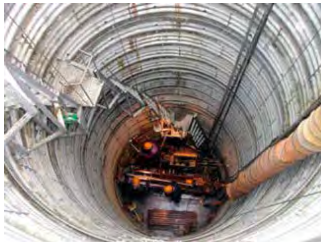
集水ボーリング施工状況
