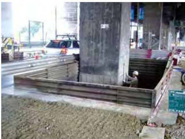
矩形施工状況
