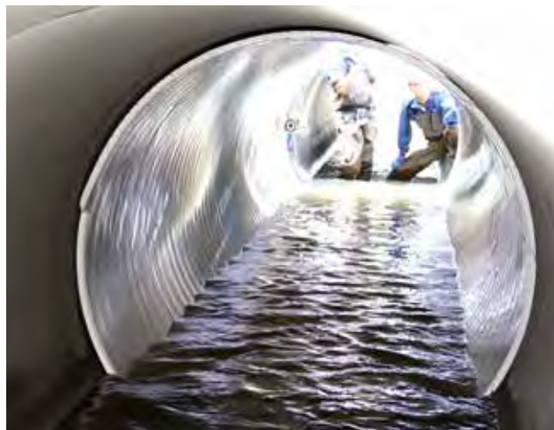
供用下での施工状況
