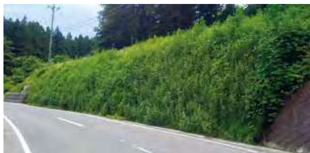
緑化状況（施工3ヶ月後）
