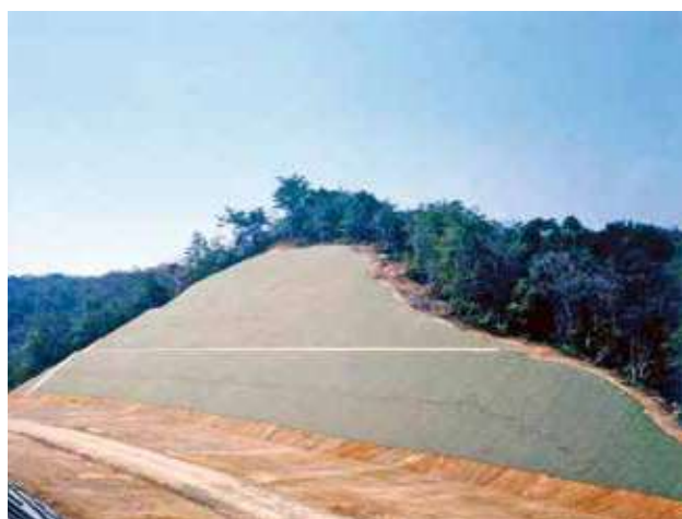
施工直後（切土）
