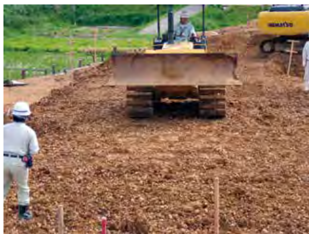
新設道路の沈下抑制（混合土）
