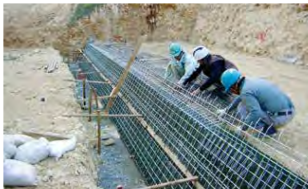
壁面材設置状況
