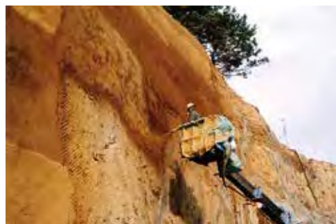
モルタル吹付工
