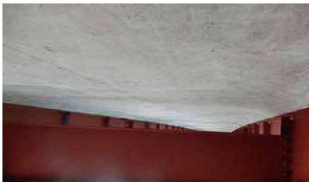
施工完了12日後
