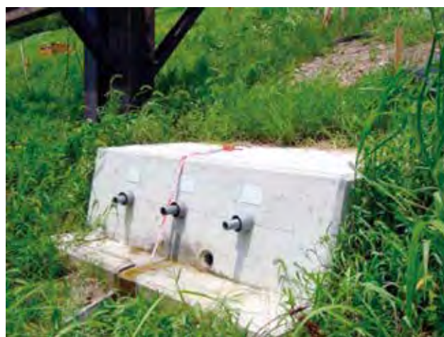
斜面排水状況
