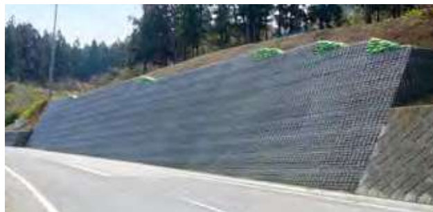
施工完了状況
