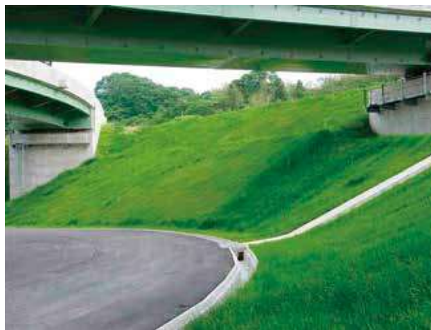
斜面緑化状況（盛土）
