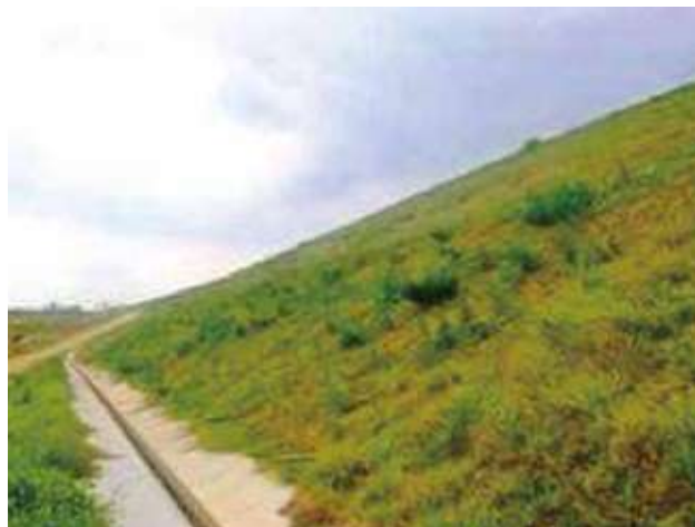
斜面盛土排水
