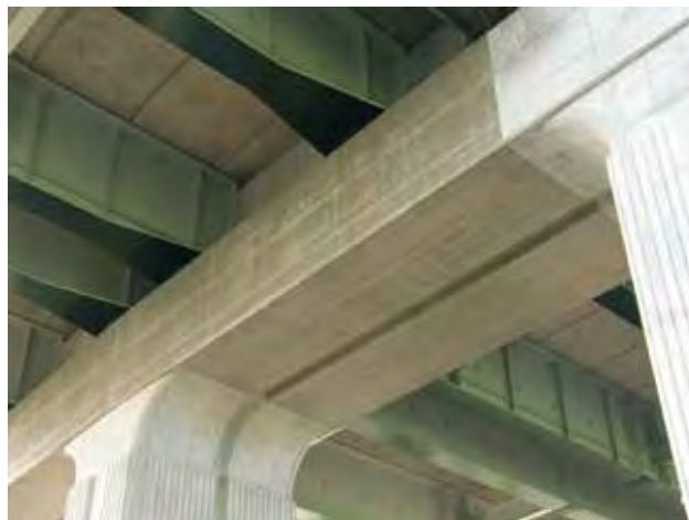
施工後10年経過後も黄変などの変状なし
