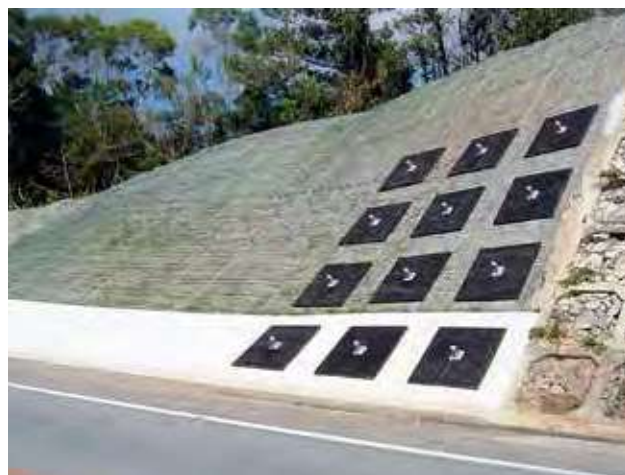
斜面補強（グリーンパネル併用）
