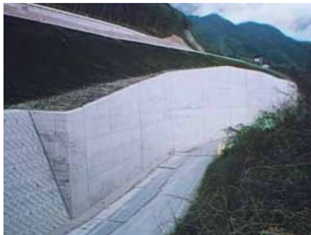
壁面完成状況
