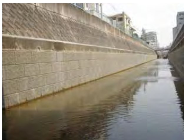
河川護岸完成状況
