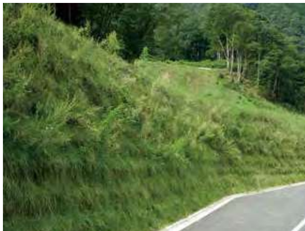
急勾配補強土壁工緑化状況
