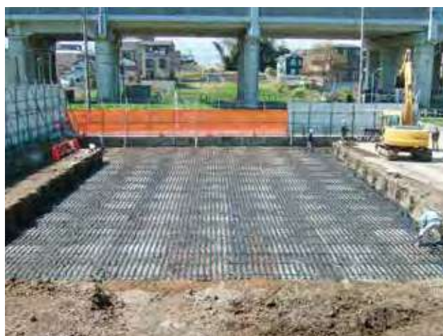
深層混合改良併用工法
