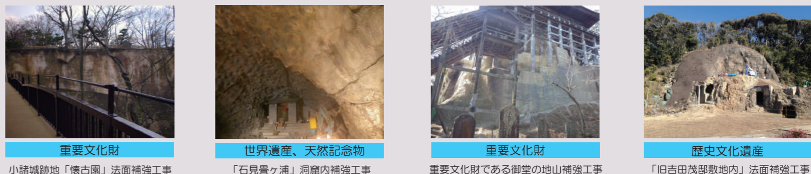
重要文化財 小諸城跡地「懐古園」法面補強工事
