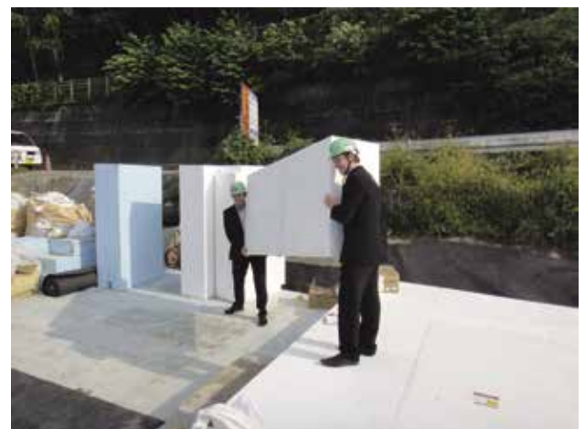
NPRA 技術者2名来日 (2010年) EDO-EPS 施工現場視察
