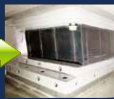
クリスタルジュエリー施工後
