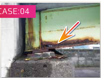
鋼板の腐食状況
