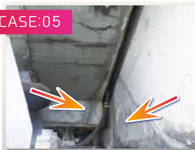
コンクリート橋 桁端部の状況
