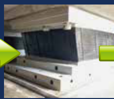
金属溶射施工後
