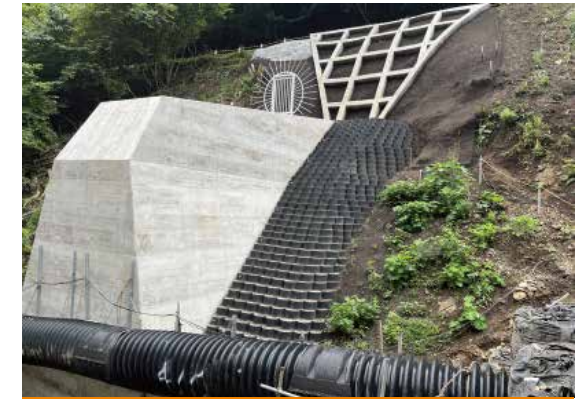
金波美沢砂防工事
