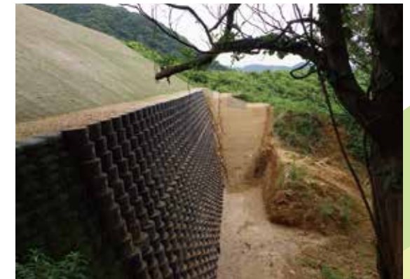
令和3年度丹後町（6）筆石農地災害復旧工事
