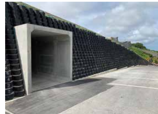
令和元年度園路広場整備他（駐車場）1
