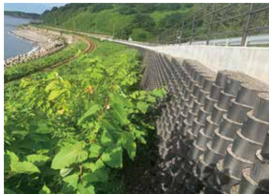
線第2144号国道101号安全対策工事
