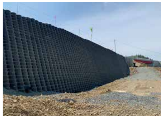
大船渡綾里三陸赤崎地区道路改良その6工事
