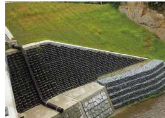
国道 304 号道路改良工事
