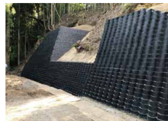
県単治山事業 尻高(関東地内)
