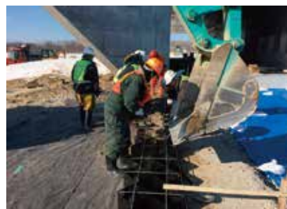
2 中詰材の撒き出し
