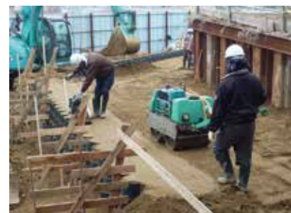
3 中詰材の締めめ
