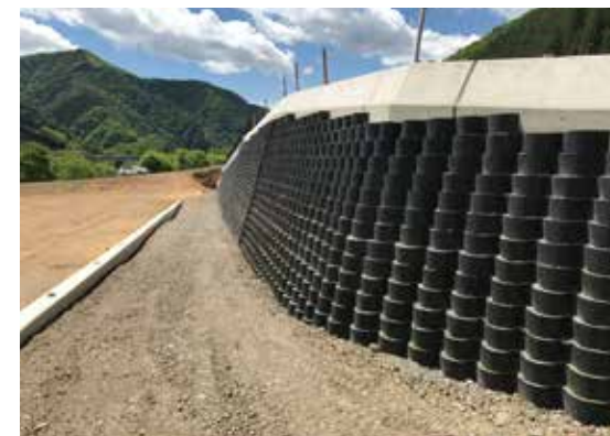
桐生市梅田台緑地改良工事
