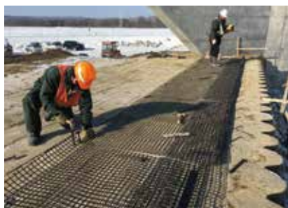
4 トリグリッドの敷設
