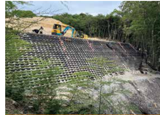
前島オートキャンプ場造成工事
