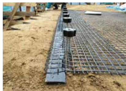
5 接続材の設置
