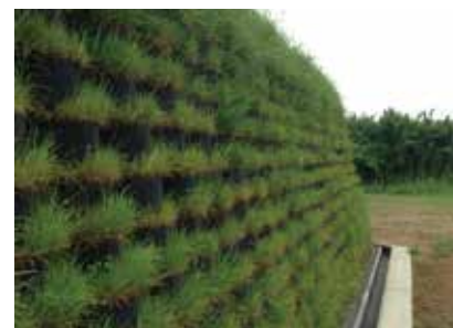
6 施工完成后（約6ヶ月）
