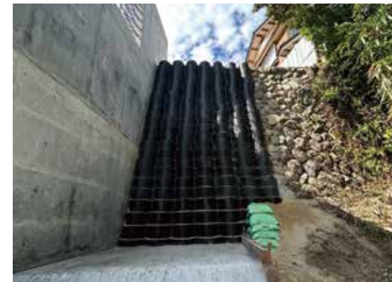
県道網代港岩見停車場線（田後工区）
