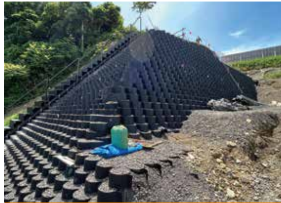
東名高速道路 静谷地区災害復旧工事
