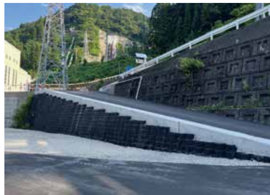
新姫川第六発電所 土木工事
