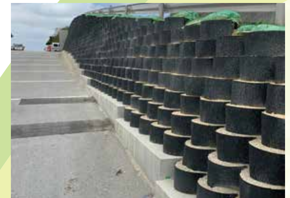
令和元年度園路広場整備他（駐車場）2
