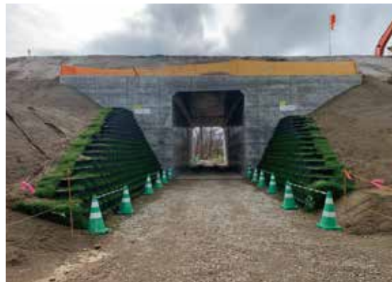
北海道横断道自動車道 釧路市 湯内改良工事 NO.6ボックス
