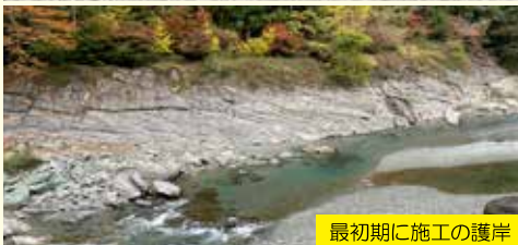
最初期に施工の護岸
