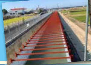
コルゲートRFフリューム 組立/解体
