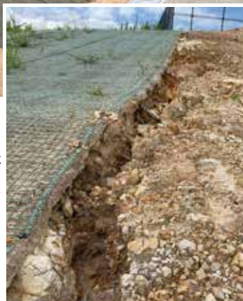
多機能フィルター施工箇所と隣地の比較
